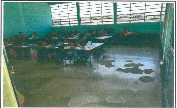
Foto 2: Mejoramiento de piso a tipo granito o ceramico
