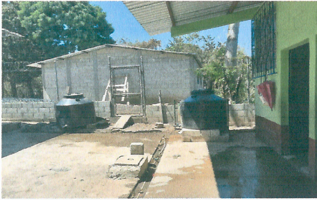
Foto 1: Suministros e instalación de tinaco con su base respectiva mas accesorios
