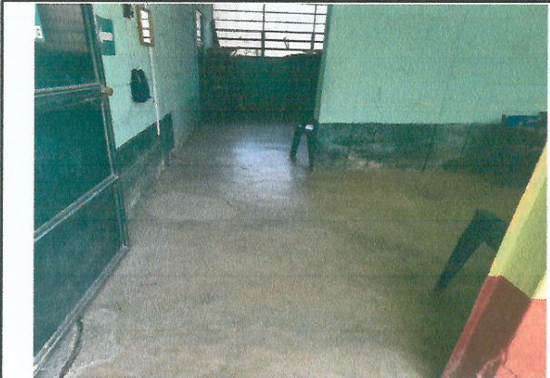
Foto 4: Mejoramiento de Pintura Interior y Exterior
