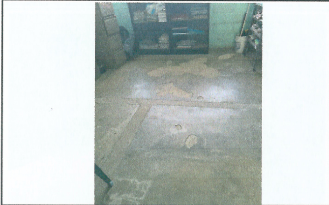
Foto 1: Mejoramiento de piso a tipo granito o ceramico
