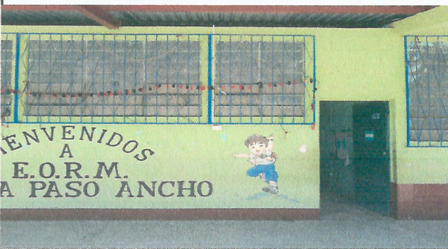
Foto 3: Mejoramiento de Pintura Interior y Exterior
